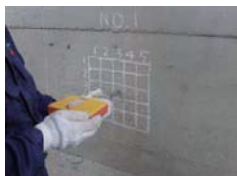
シュミットマーによるコンクリート強度調査
