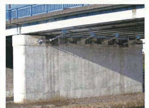
耐震対策後(落橋防止装置)
