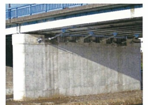
耐震対策後(落橋防止装置)
