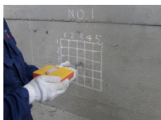
ハンマーによるコンクリート強度調査
